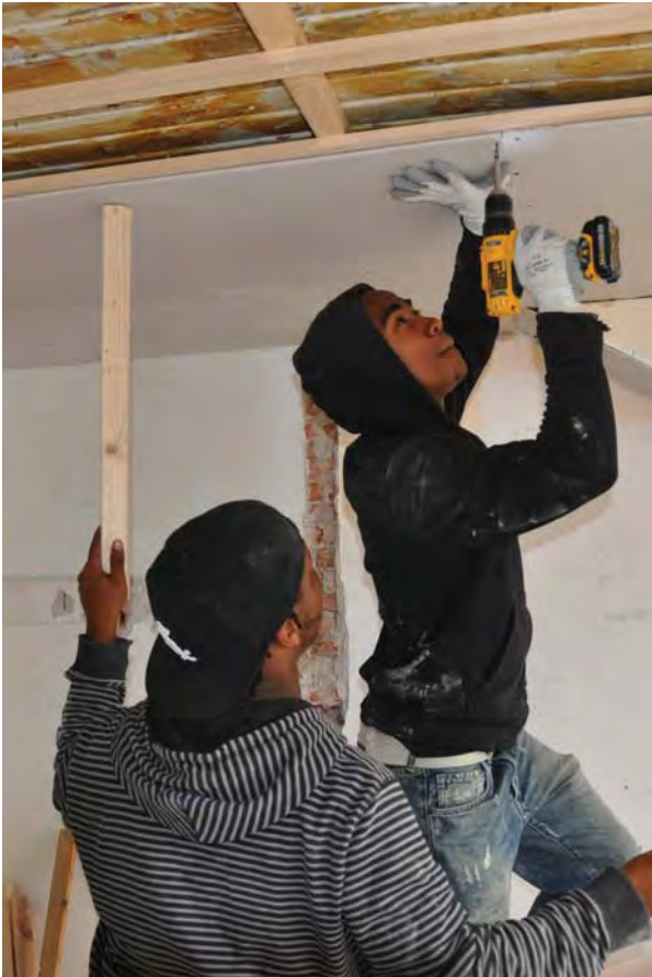
Studenten Albeda-collega reneveert woning
