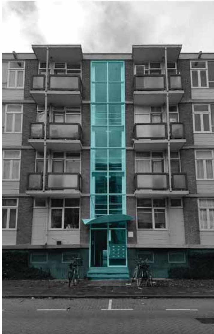
Foto 14. Portiek entré vierlaagse portiekflat, bron: eigen foto.
