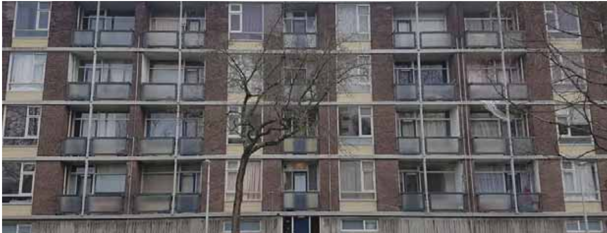
Foto 2. Gevelaanzicht locatie Zuidwijk, bron: eigen foto.
