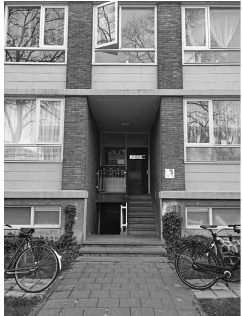
Entree portiek (3-bouwlagen)
