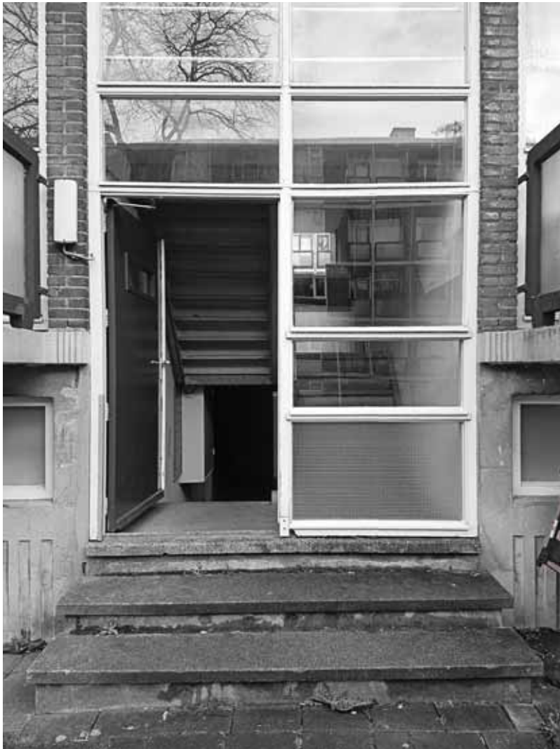
Entree portiek (4-bouwlagen)
