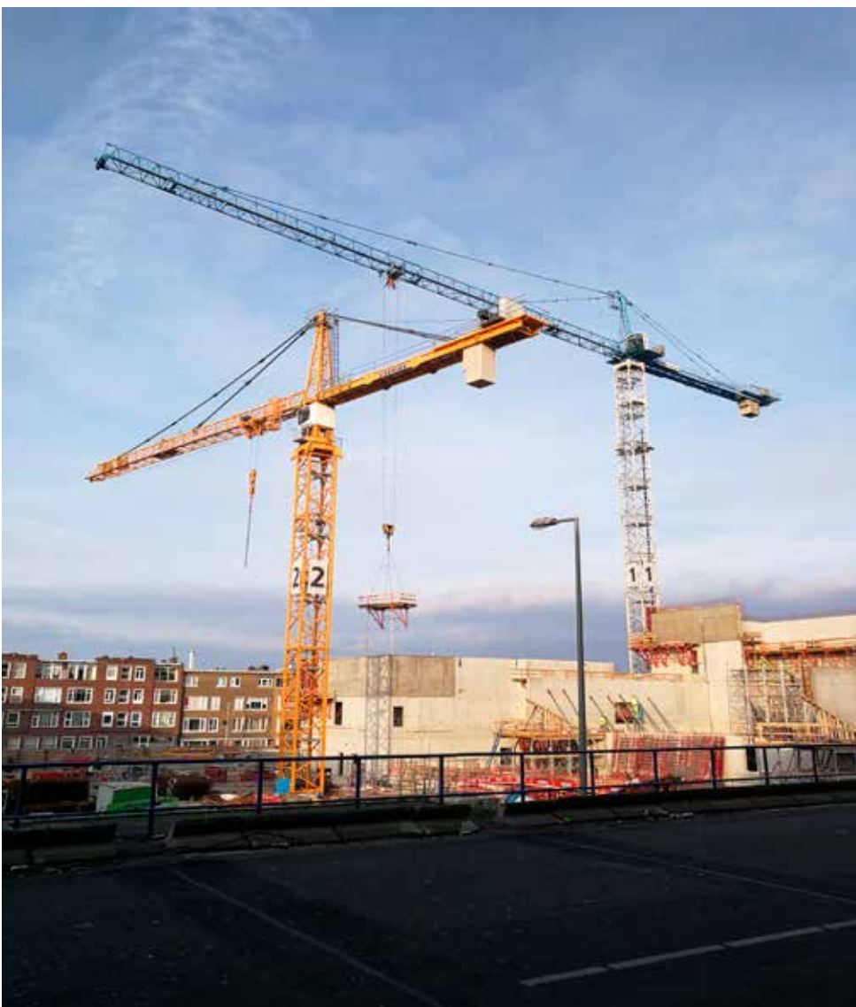
Figuur 2 Bouwactiviteiten gezien vanuit het metrostation
