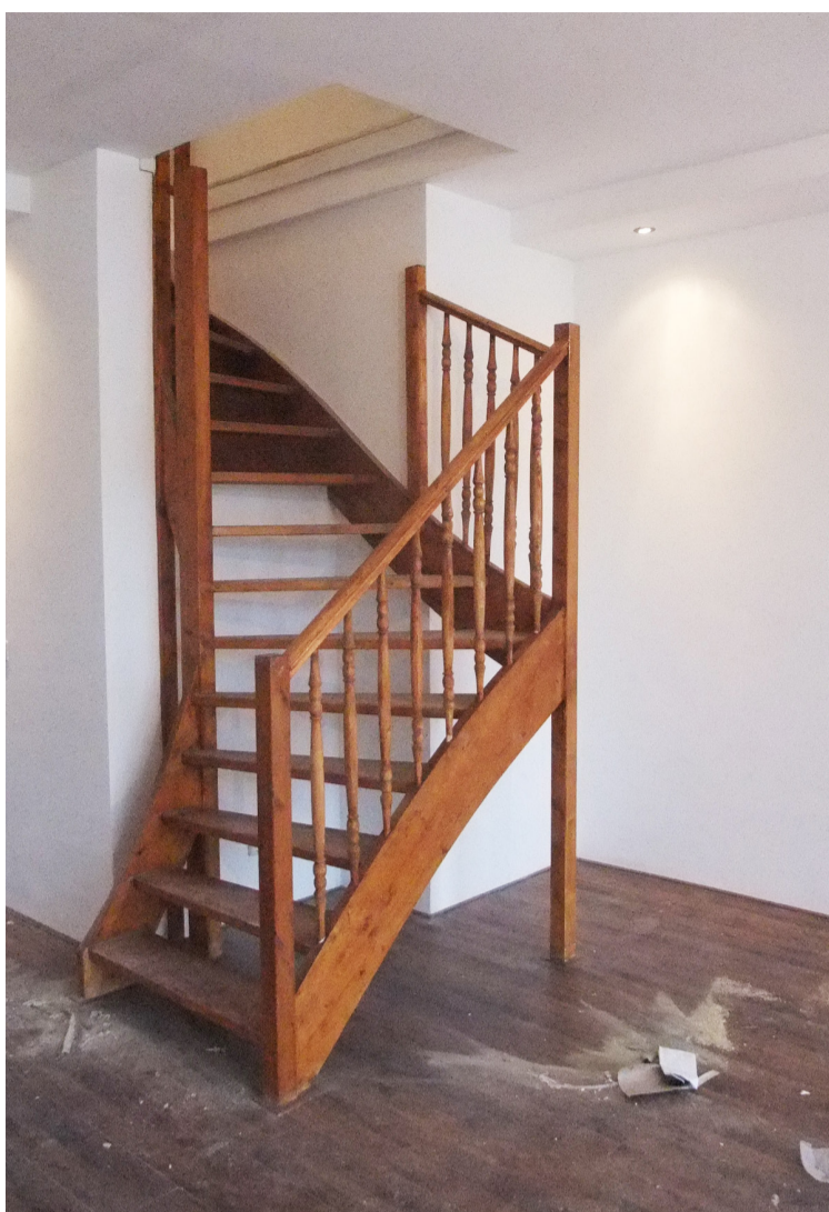
De trap wordt geplaatst waarbij de bovenwoning bereikbaar wordt
