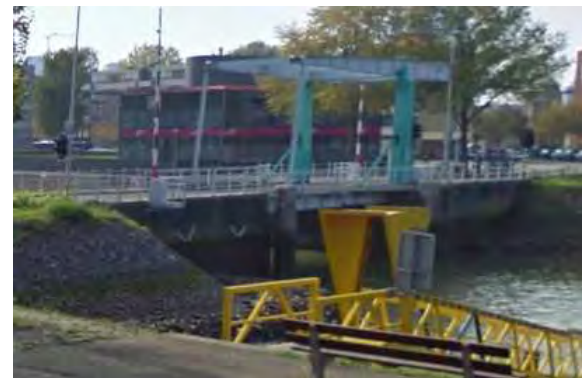
Figuur30. Huidig uiterlijk Nassaubrug
