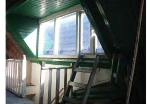
zolder, dakkapel in het midden van de verdieping
