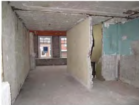
tweede verdieping, rechts de trap
