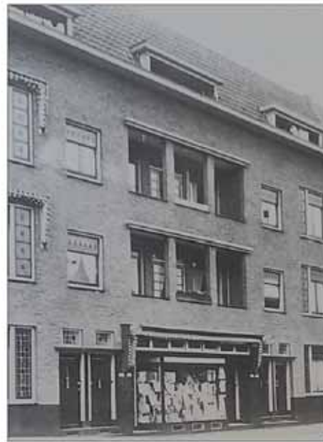
afb. 2.06 Oudeveerd Ooststraat voor de tweede verbouwing Lijpdonckse bakken, smelt glasloof en aansluiting op de kroon
