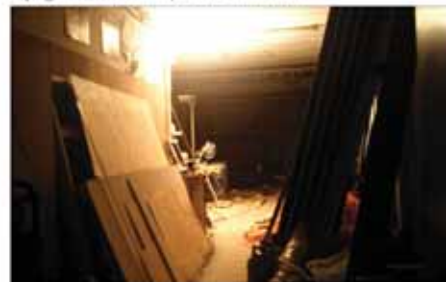
afb. 3.18 atelier pand Ooststad 25 Atelier pand in woonw. 11 februari '06
