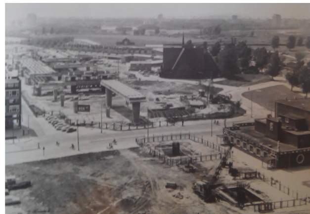
Bouw Metro Zuidplein, uit Stichting Historisch Charlois. (2014, september 5). Na-oorlogse noodwoningen Charlois; Verdwenen maar niet vergeten. Het Brabantse Dorp , pp. 1-79.
