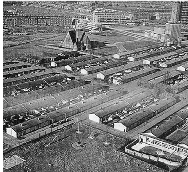
Het Sociaal Cultureel centrum (rechts onder op de foto), ±1960, uit Meijel van, L., Hinterthür, H., & Bet, E. (2008). Cultuurhistorische verkenning vooroorlogse wijken Rotterdam-Zuid . Rotterdam.
