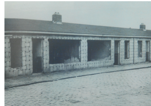
Behoud oude gevelindeling, uit Stichting Historisch Charlois. (2014, september 5). Na-oorlogse noodwoningen Charlois; Verdwenen maar niet vergeten. Het Brabantse Dorp , (p. 43).
