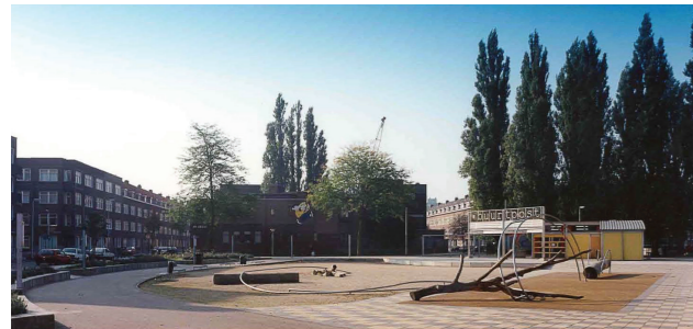
Millinx buurtpost, Nieuwbouw activiteiten- en ontmoetingscentrum, uit infoblad Millinx buurtpost Lüthi & Niclaes
